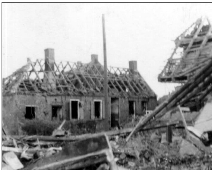
Zerstörungen im Dorfkern von Larrelt
